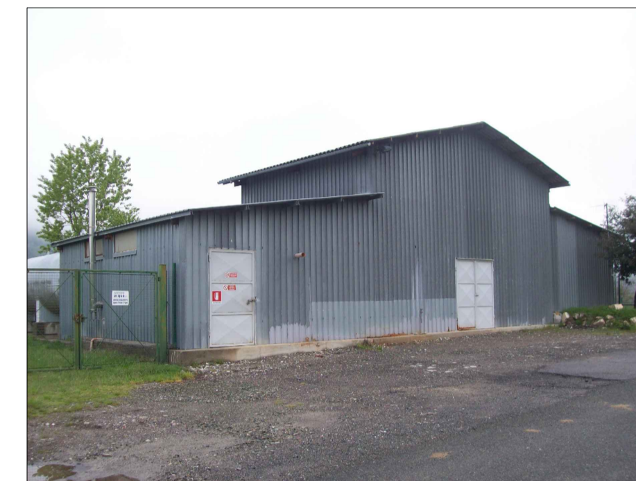
Edificio contenente l'impianto di potabilizzazione
